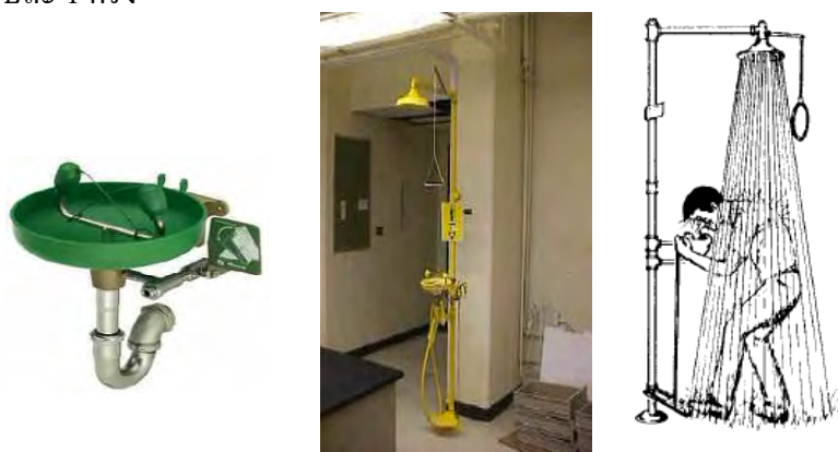
ภาพที่ ผ.4 อ่างล้างตา และที่ล้างตัวฉุกเฉิน
