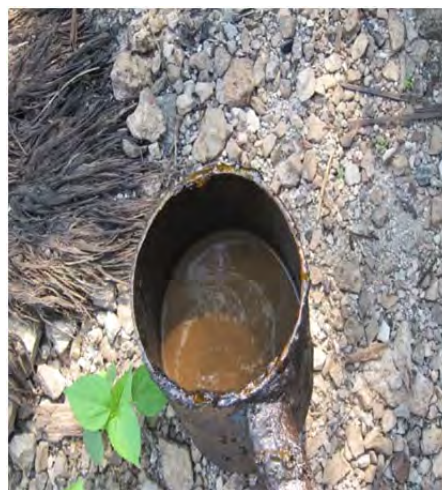
ภาพที่ 3 ลักษณะน้ำทิ้งบ่อแรก
